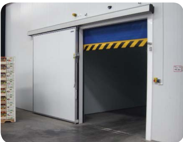
Rolling rapid door for preservation, combined with an IF sliding door Fruit and vegetable industry (Kabbaj, Morocco) Porte rapide enroulable combinée porte coulissante IF Industrie maraîchère (Kabbaj, Maroc) Schnellaufrolltor für Kühlageräume kombiniert mit Schiebetür IF Obst- und Gemüseindustrie (Kabbaj, Marokko)
