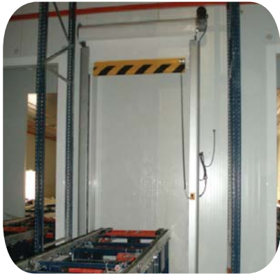
Freezer rapid roll-up door used with an automatic conveyor Porte rapide enroulable de congélation en combinaison avec système automatisé de transport de palettes Schnellaufrolltor für Tiefkühlräume in Kombination mit einem System zum automatischen Transport der Paletten
