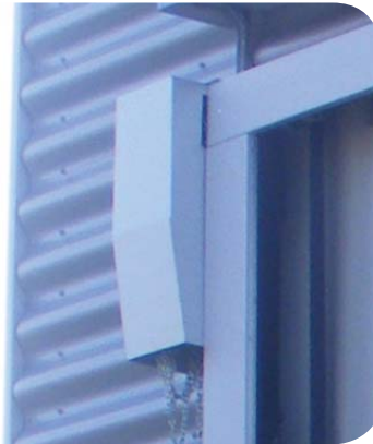
Rapid fold-up door motor-cover Couvre-moteur pour porte rapide à empilement Motorabdeckung des Schnellfalttors
