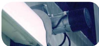
Freezer rapid roll-up door protected motor Moteur protégé porte rapide de congélation Geschützter Motor der Tiefkühlraumtür
